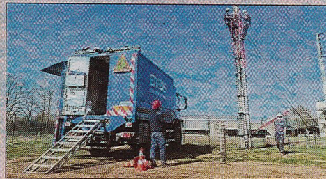
Démonstration de travaux sous tension par une équipe d'Enedis sur le plateau technique du Greta d'Ambérieu, unique dans l'Ain.
