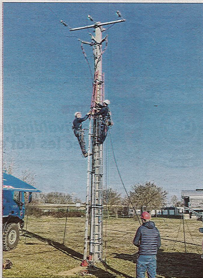
Chez Enedis, les techniciens en réseaux électriques entretiennent et réparent entre autres les réseaux aériens. Photo Progrès/Olivier CALLAMAND
