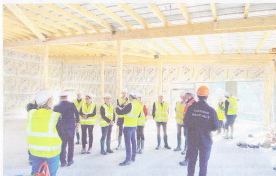
Lycée Plaine de l'Ain, le chantier avance comme prévu, la livraison, fixée pour la rentrée de septembre 2023, semble tenue, une enveloppe complémentaire a été validée par la Région. Photo : LB
