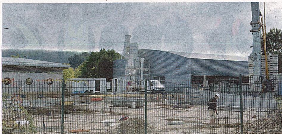
Le coût des travaux financés par la région s'élève à 1,5 M€. Photo : Laurence Bonant
