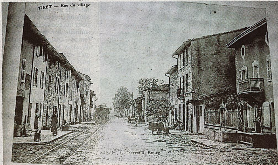
La rue A. BERARD dans la traversée du Tiret À gauche le Tacot qui arrive, à droite la fontaine du Trémollard
