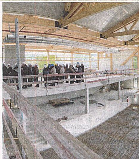
Vue intérieure du nouveau bâtiment Logistique, 1 200 m 2 , hauteur de 12 m, et un étage. Photo: Laurence Bonant
